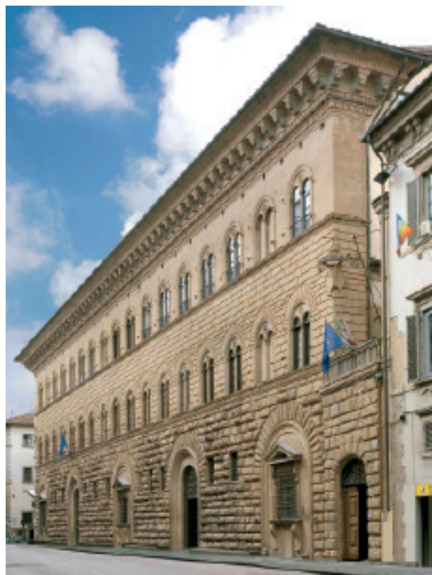
Slika 2. Pročelje s rustikom, palača Medici
